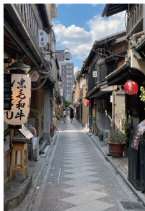
無電柱化工事が終わった先斗町の今。
